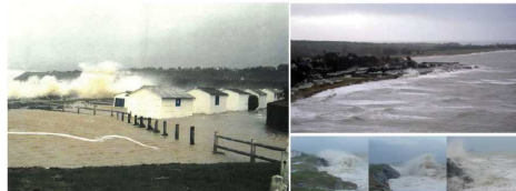
Figure. Franchissements par paquets de mer lors de la tempête de mars 2010 (DDTM50)
