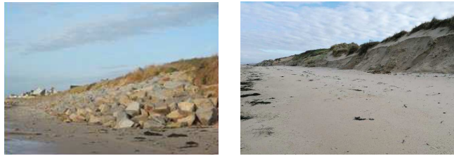
Limite sud du perré en enrochement au sud de Pirou-Plage (à gauche) et état du littoral sud de Pirou-plage au 27 mars 2023, suite au coup de vent des 23 et 24 mars (à droite)
